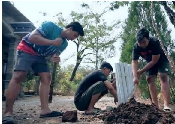
Gambar 4. Pengecoran Pipa PVC
