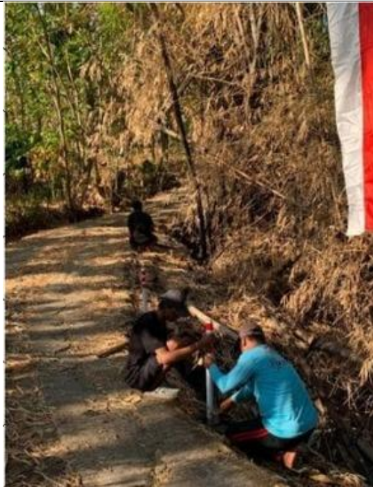
Gambar 6. Proses Pemasangan Reflektor
